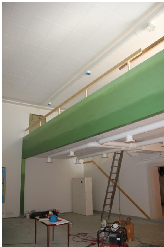
Bildet viser mezzaninen, bygget med limtre som inngikk i leveransen fra Mjøselement.
